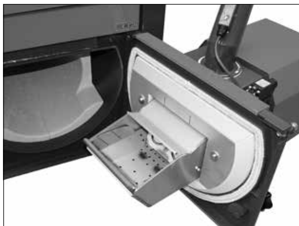
Otwarta dolna komora kotła podczas czyszczenia komory spalania i palnika ATMOS A45
