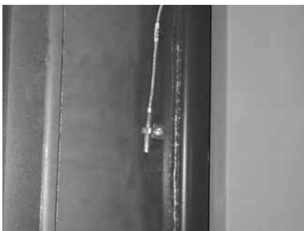
Rys. 15 - widok czujnika temperatury spalin TSV na boku kanału spalinowego kotłów DCxxSP(X), CxxSP, ACxxSP
