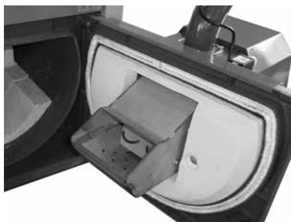
Otwarta dolna komora kotła podczas czyszczenia komory spalania palnika ATMOS A25
