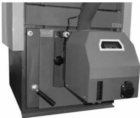
Palnik na pelety ATMOS A25 w dolnej komorze kotła
