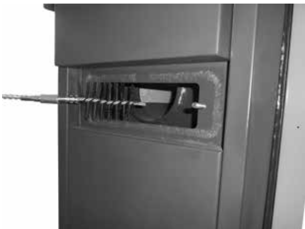
Ilustracja czyszczenia środkowej części kanału dymowego - środkowa pokrywka
