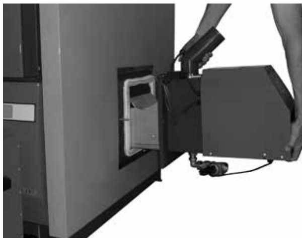
Wyjęcie palnika z kotła przy corocznej konserwacji i czyszczeniu
