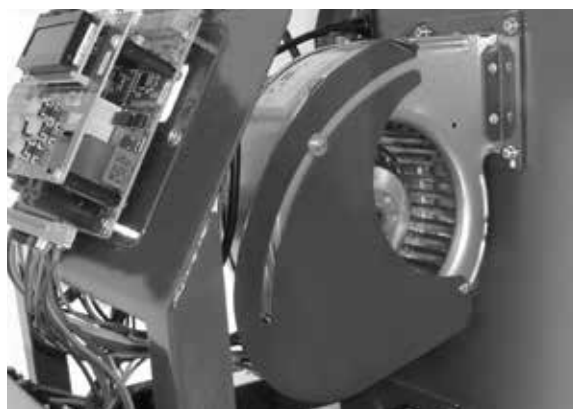
Wentylator palnika z przepustnicą powietrza. Otwarcie przepustnicy powietrza powoduje skrócenie długości płomienia.
