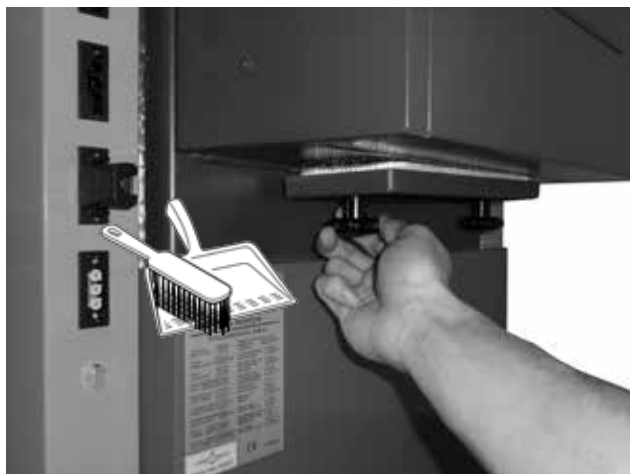
Ilustracja czyszczenia kanału dymowego w tylnej części kotła
